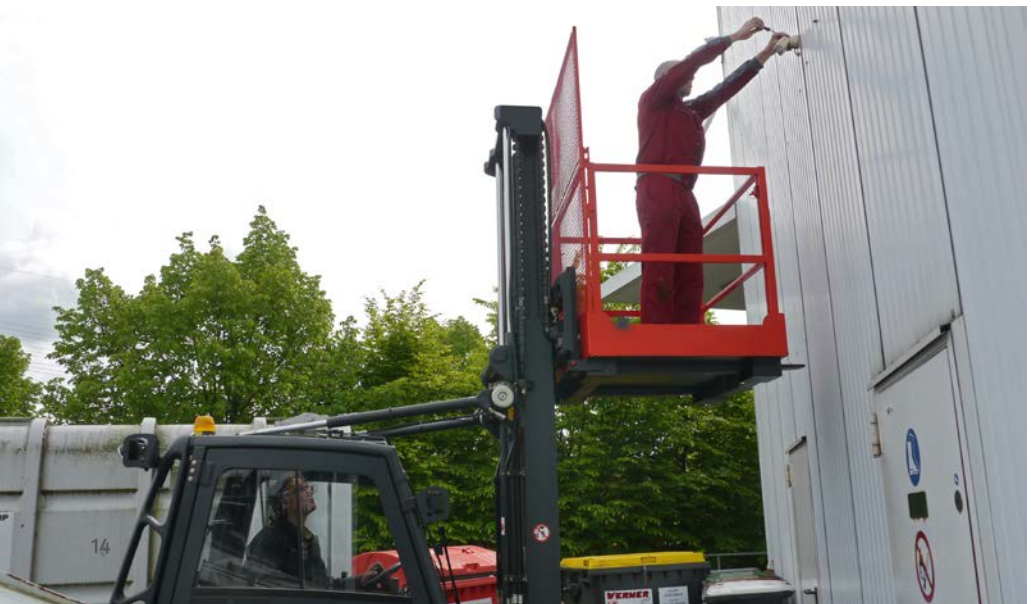
Abb. 4 Durchführung von Reparaturarbeiten aus der Arbeitsbühne. Der Fahrer darf den Fahrerplatz bei angehobener Arbeitsbühne nicht verlassen
